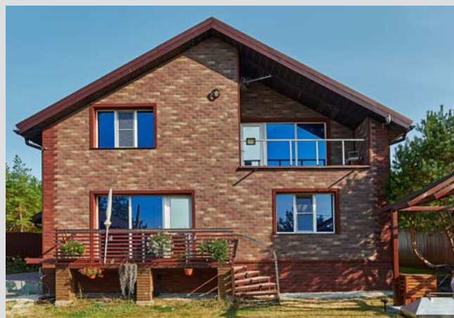
Объект «ПОСЛЕ». Коллекция КИРПИЧ, цвет Английский кирпич
