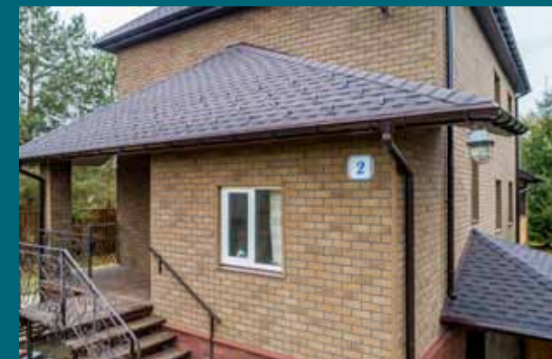
Объект «ПОСЛЕ». Коллекция КИРПИЧ, цвета Песчаный кирпич и Терракотовый кирпич
