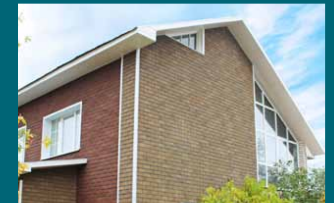
Объект «ПОСЛЕ». Коллекция КИРПИЧ, цвета Песчаный кирпич и Терракотовый кирпич
