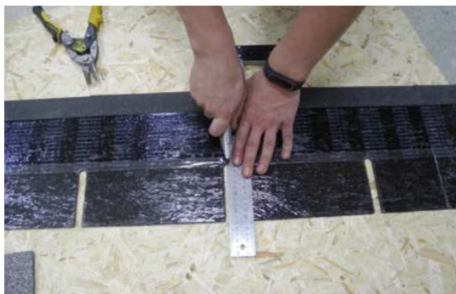
Рис. 13. Деление плитки на лепестки
