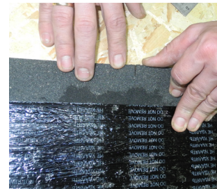
Рис. 76. Насечка для облегчения монтажа
